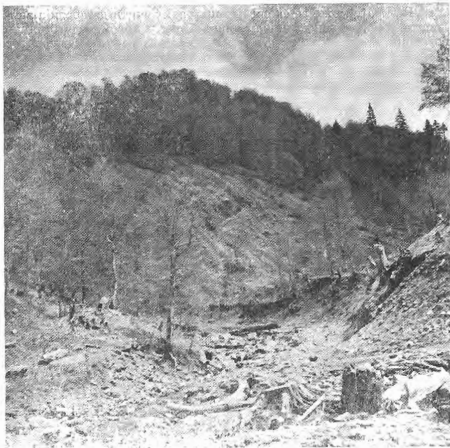
Сл. 8. Шумски пут коритом Журен потока посјетио је ерозионо дјеловање воде
